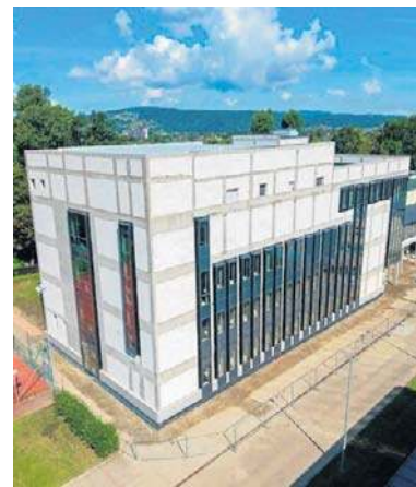
Budowa rozpoczęła się w lipcu 2024 roku
