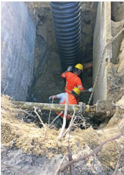
„Budowa sieci kanalizacyjnej ul. Wojska Polskiego dopływ z Białowiejskiej i 17 Sierpnia oraz przebudowa kanalizacji ogólnospławnej”
