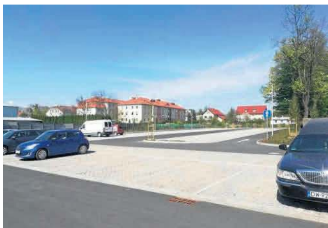
Mimo że parkingi park&ride świecą pustkami - są zamknięte
