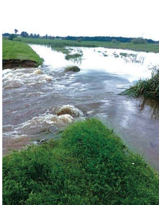
Przerwany wał przeciwpowodziowy w Świętym Gaju
