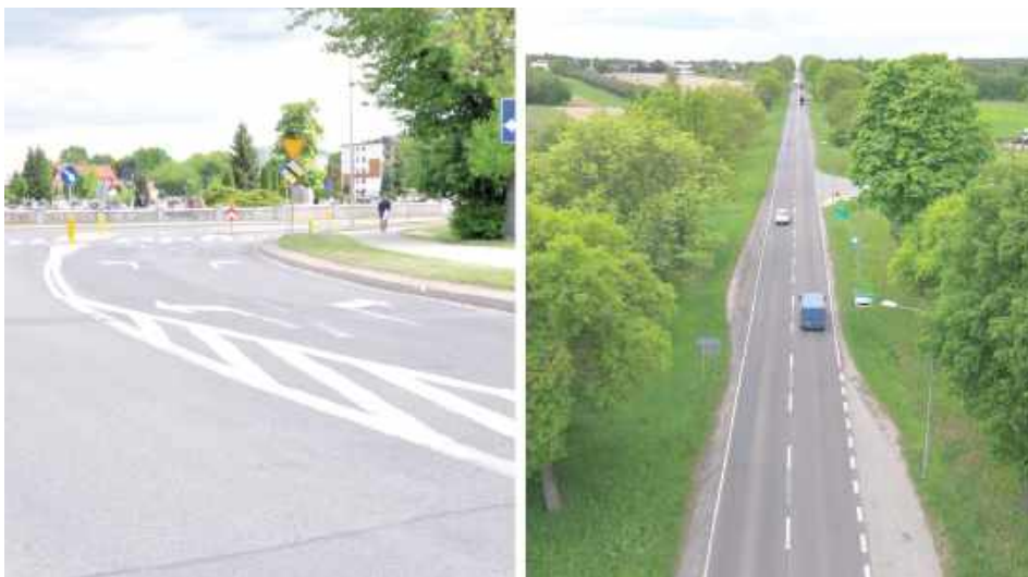
Rozbudowa obejmuje dwa główne fragmenty trasy: od mostu na Wiśle do wiaduktu nad linią kolejową (ok. 2 km), od wylotu z Dębłina do Moszczanki (ok. 6 km). Wartość inwestycji wynosi 95,5 mln zł, a zakończenie prac planowane jest na 2027 rok
