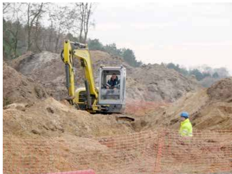
Obwodnica - pierwsze prace na ul. Pomorskiej
