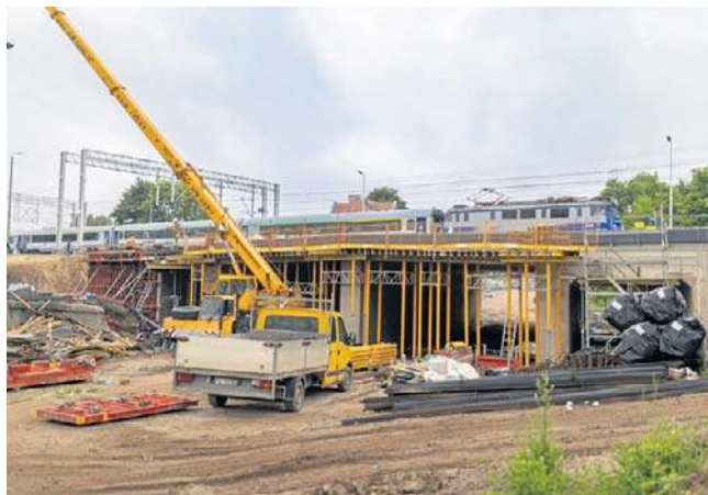
Wiadukt kolejowy nad ul. Szczecińską będzie gotowy w IV kwartale br.
