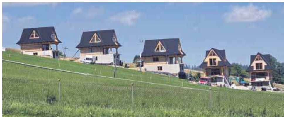
- Wierzę, że prędzej czy później sąd nakaże rozbiórkę tych „poidełek” i skutecznie powstrzymamy inwestora - mówi Grzegorz Józkiwicz, przewodniczący zakopiańskiej Rady Miasta.
