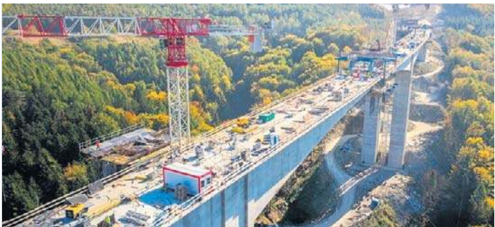
Estakady będą wyższe niż wieża Bazyliki Mariackiej
