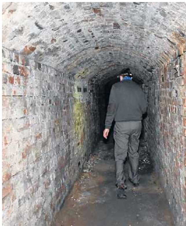
Szczelina przeciwlotnicza ma 60 metrów długości
