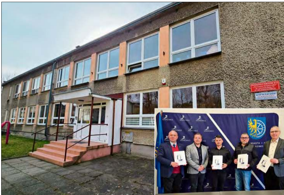
Otmękie przedszkola przejdą gruntowny remont termoizolacyjny.
