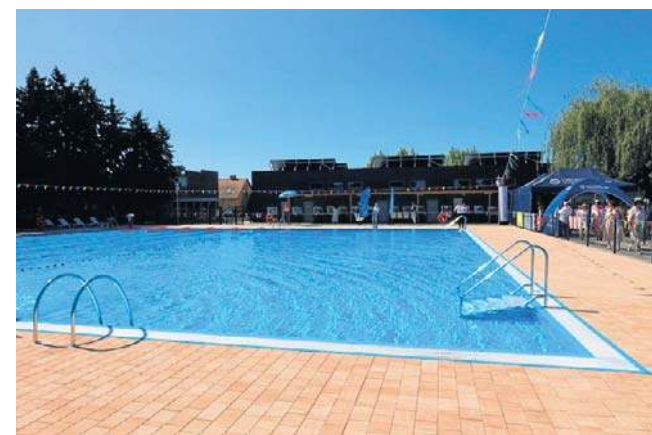
W budynku przygotowano pomieszczenia dla obsługi i ratowników, szatnie, zaplecze sanitarne oraz pomieszczenia technologiczne
