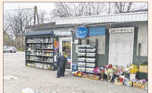
BOROWIE, ul. Garwolińska 13: Kiosk „Zielona Budka”
