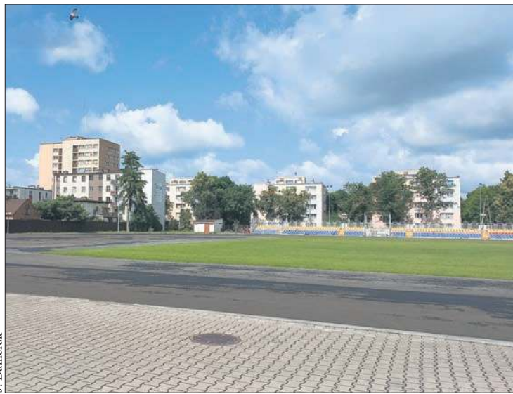
Trwa przebudowa Stadionu Miejskiego im. Bernarda Szymańskiego
