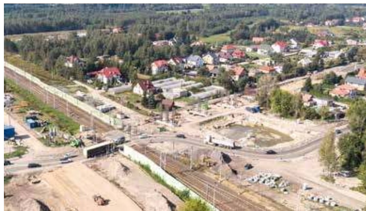
Budowa wiaduktu z lotu ptaka
