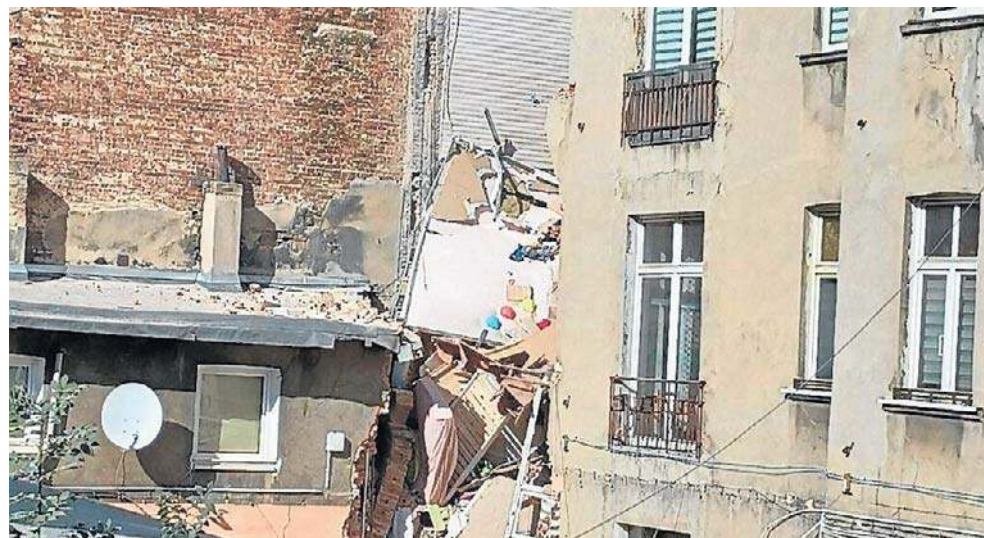
We wrześniu minął rok od zawalenia się kamienicy przy ul. 1 Maja w Łodzi, pod którą drażony jest tunel
