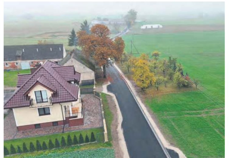
Wykonanie nowego 2,5-kilometrowego odcinka drogi kosztowało nieco ponad 1,5 mln zł.
