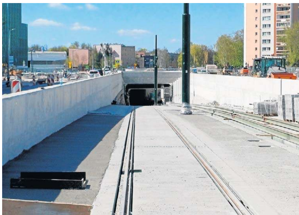
Na ukończeniu jest budowa linii tramwajowej z ul. Meissnera do pętli w Mistrzejowicach
