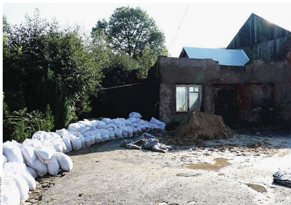
Pierwsze inwestycje mają zabezpieczyć mieszkańców na wypadek powodzi
