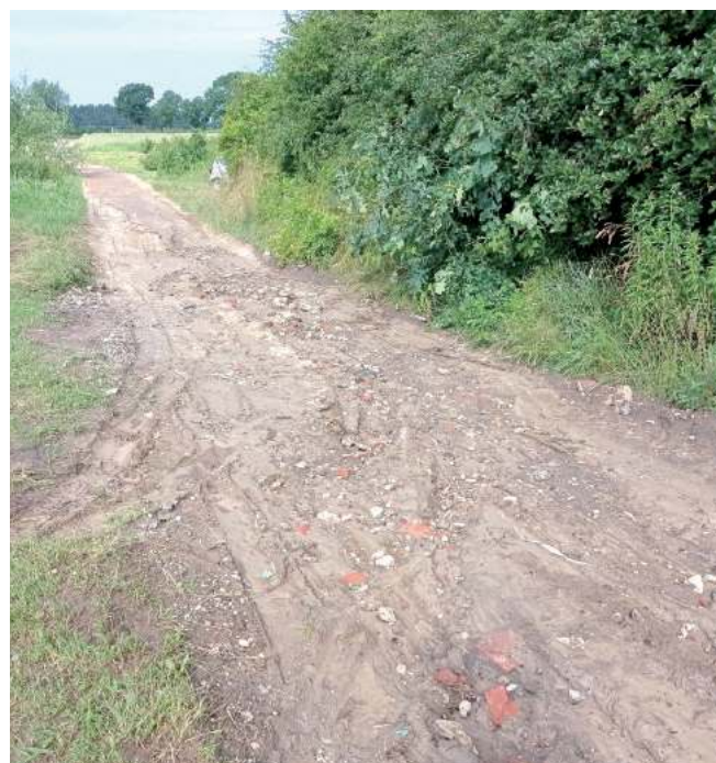
Zdjęcie UG w Karczmiskach. Tak wygląda ulica Wesoła po wykonaniu prac przez gminę związanych z usunięciem wyrwy i zapewnieniu przejeźdźności
