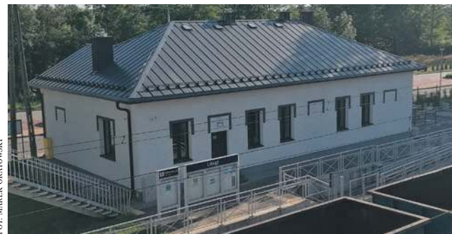
Na potrzeby domu został zaadaptowany budynek dworca PKP
