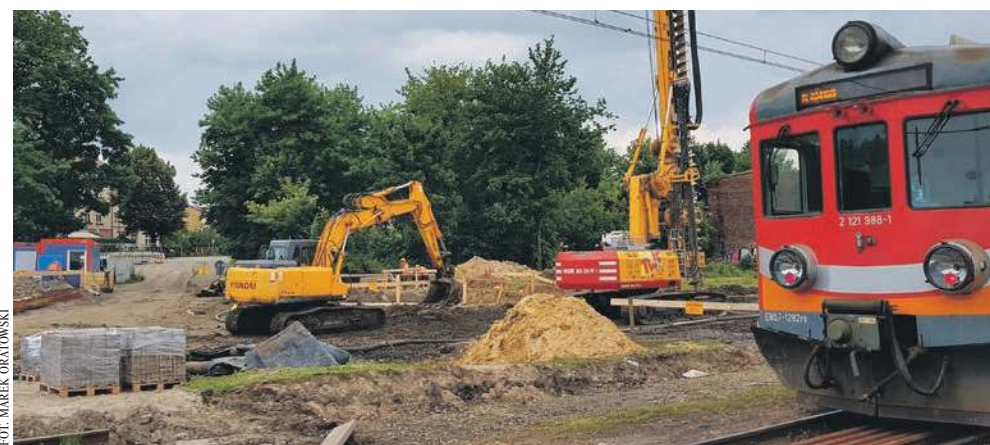
Stacja jest jednym wielkim placem budowy. Więcej zdjęć można obejrzeć na www.przelom.pl
