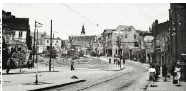
Zniszczone przez sowieckich żołnierzy kamienice przy obecnej ulicy Prostej (druga połowa lat 40. XX wieku). Widok od strony mostu św. Jana Nepomucena
