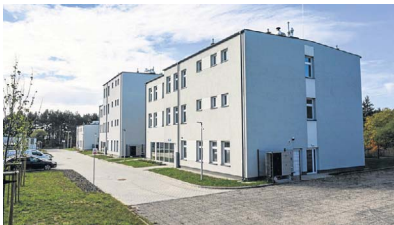
Przy Kaplicznej zakończyła się budowa nowego ośrodka
