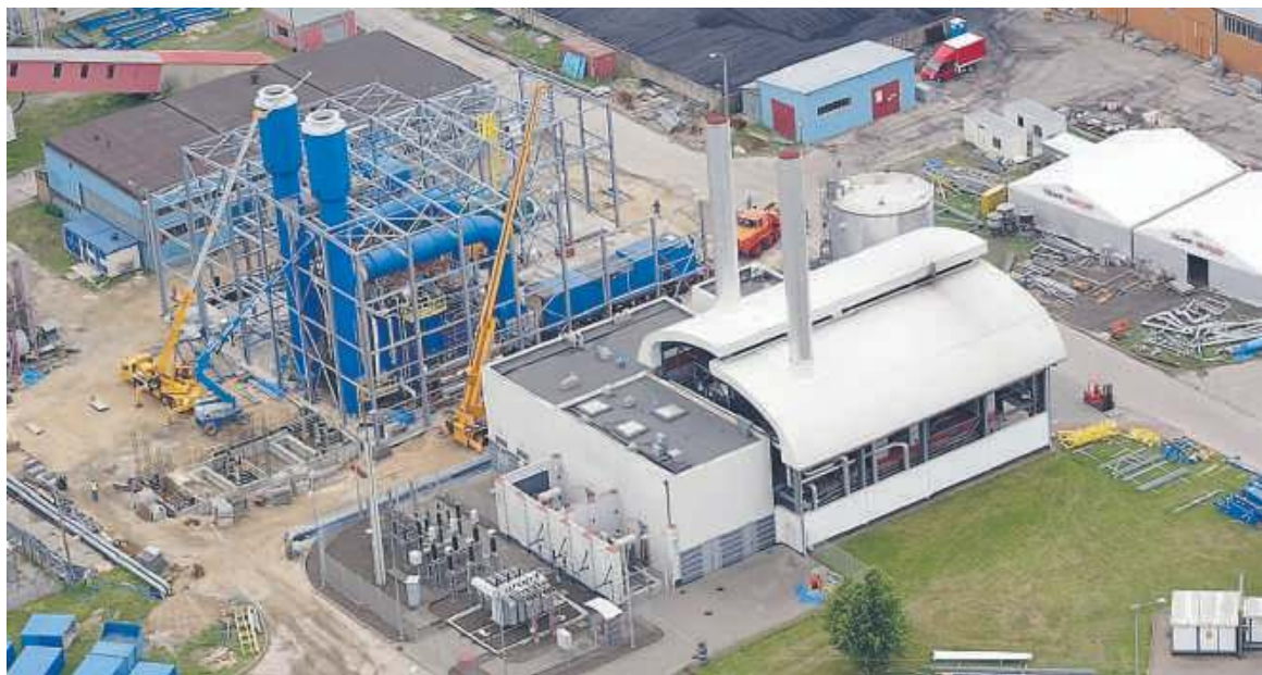
Elektrociepłownia EC2 w budowie – 2011 r.
