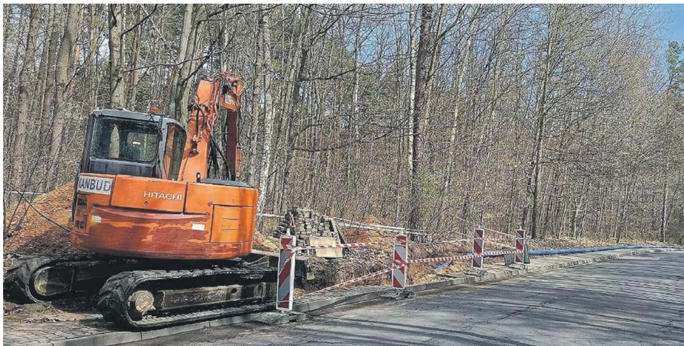
Rozbudowa sieci wodociągowej z Czyżówki
