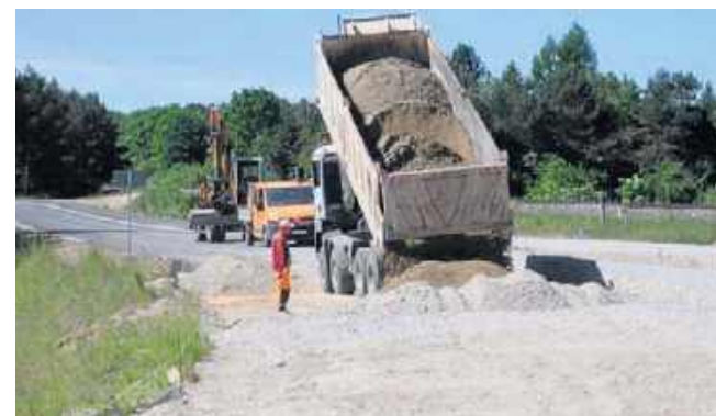
Wykonawca skupia się na pracach drogowych, które wchodzą w końcową fazę.
