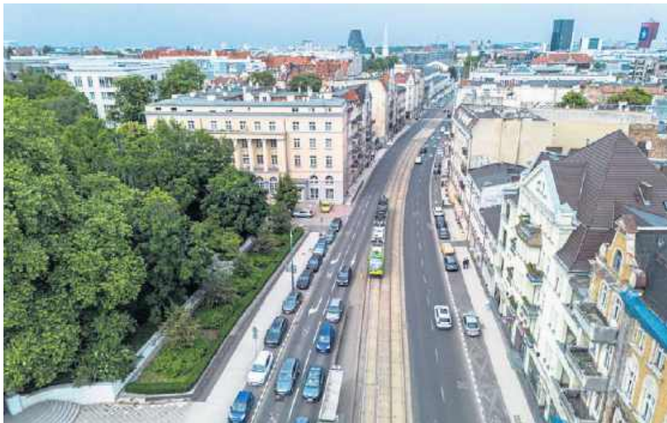
Ulica Głogowska pozostaje jednym z najważniejszych problemów osiedla. Zamiast łączyć - dzieli. Dla tych, którzy chcą przejść rowerem do centrum Poznania pozostaje nieprzyjazna. Dla tych, co chcą tam dojechać rowerem - wręcz niebezpieczna.
