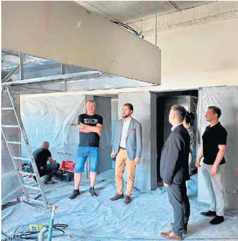
W Skokach powstaje samorządowy żłobek „Skaczące Brzdące”.
