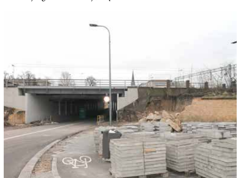
Prace na wiadukcie chwilowo stanęły ze względu na napotkanie przez pracowników kabli elektroenergetycznych
