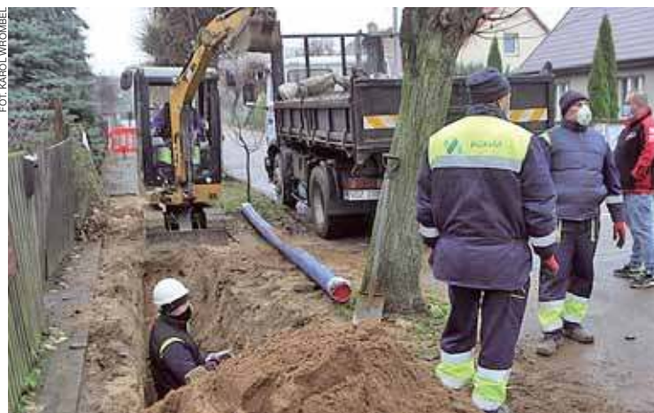
Aktualnie wymieniana jest sieć wodociągowa
