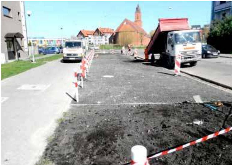
Na ulicy Miłej utwardzono 180 m 2 powierzchni i położono geokratę
