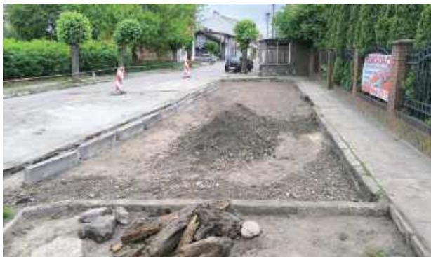
Trwają prace remontowe na ul. Białej w Łaskarzewie
