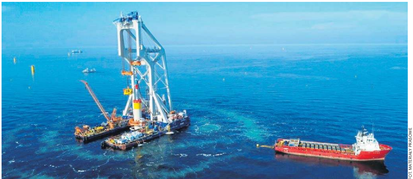
Instalacja elementów przejściowych morskich wież wiatrowych na Baltic Power dobiegła końca
