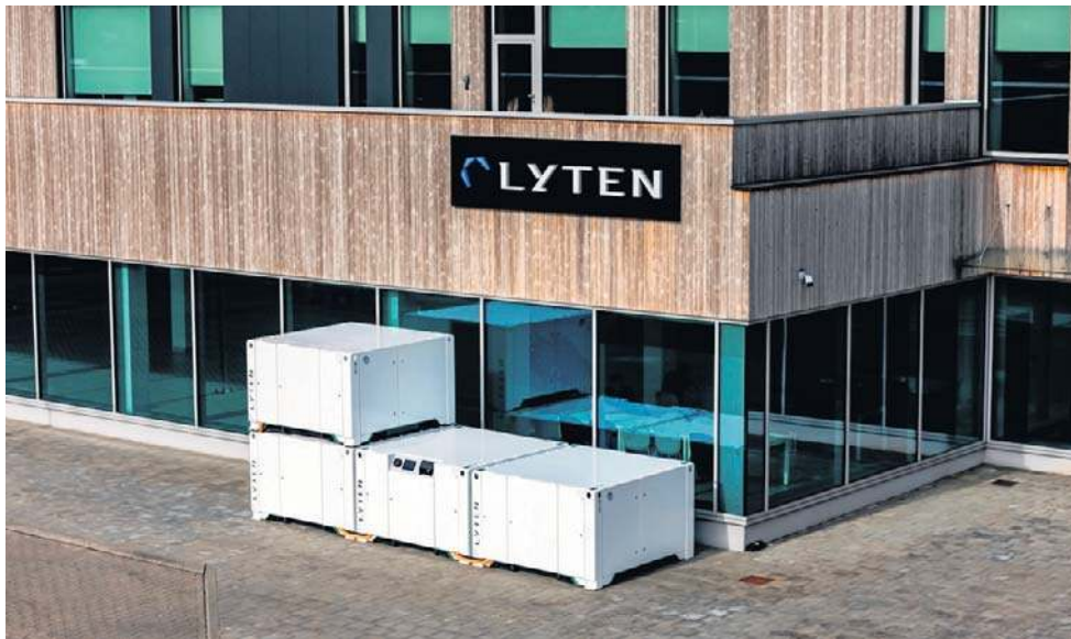
Zakład produkcyjny Lyten i centrum R&D bateryjnych magazynów energii w Gdańsku
