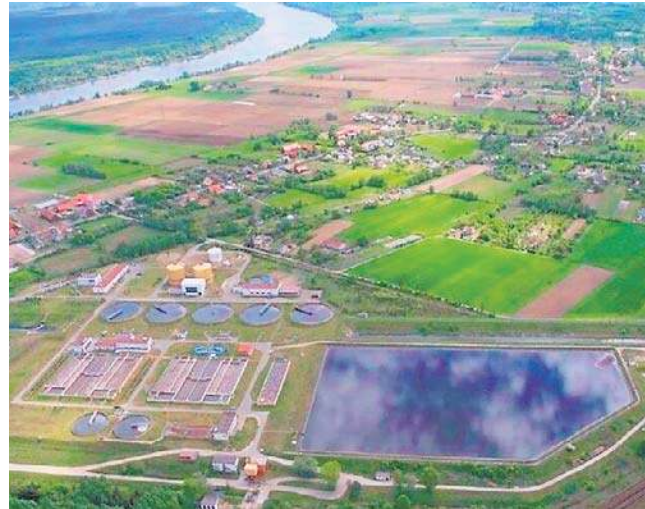
Bydgoska oczyszczalnia Kapuściska
