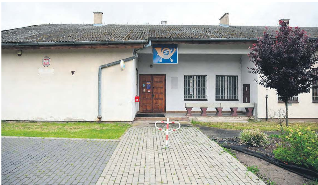
Placówka pocztowa miała zmienić adres na centrum Kęsowa i znajdujący się w nim nowy blok. Plany uległy zmianie.
