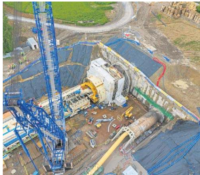
Tak wygląda plac budowy na tym fragmencie linii kolejowej Podłęże - Piekiełko
