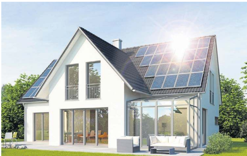
Domy z prefabrykatów wyróżnia krótki czas budowy, precyzja wykonania oraz energooszczędność.
