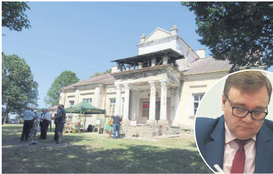
– Budynek jest opuszczony. Postanowiliśmy go odnowić i zagospodarować – mówi Adam Wal.
