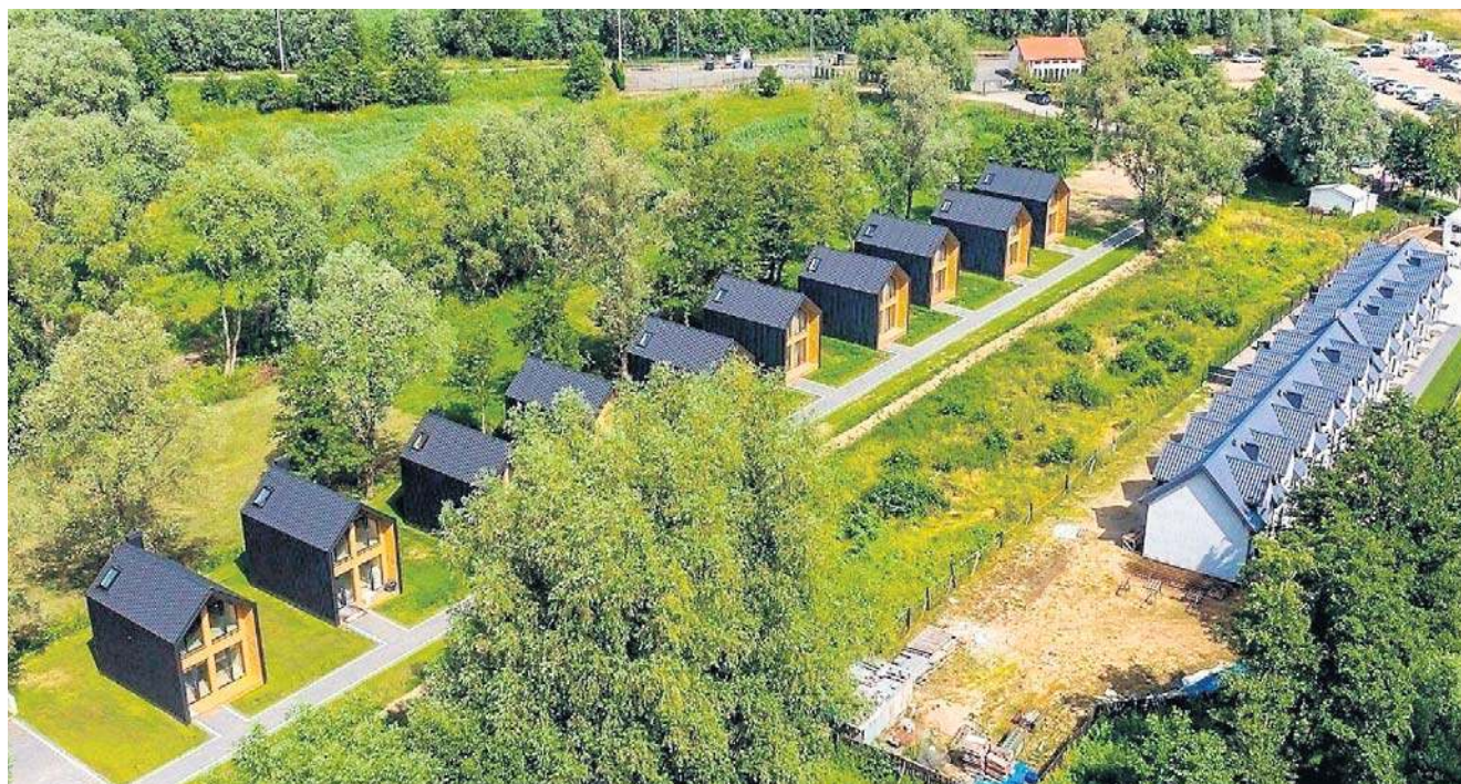
Domki covidowe w Mechelinkach to słynny przykład samowoli budowlanej. Zapadła decyzja o ich rozbiórce
