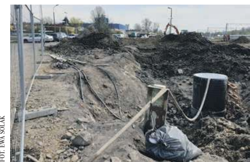
Prace budowlane przy stacji
