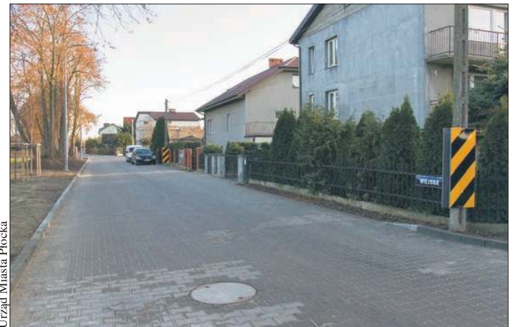
Zakończył się pierwszy etap budowy ulicy Wiejskiej
