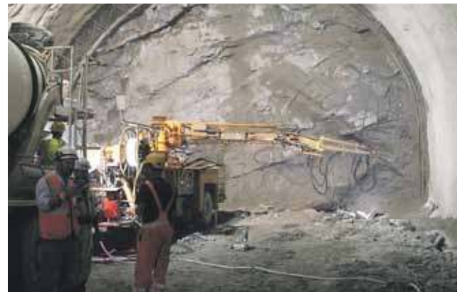
Początek tunelu od południowej strony Małego Lubonia.
