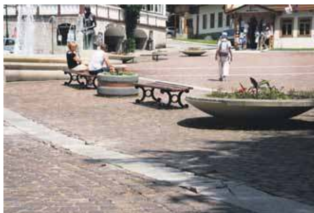
Poniszczona kostka brukowa straszy na placu Dietla w Szczawnicy.
