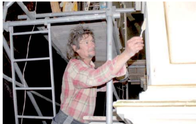
Trwają już prace przy ołtarzach bocznych
