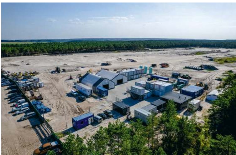
Miejsce budowy elektrowni atomowej w Stajszewie. 13 sierpnia 2025 r.
