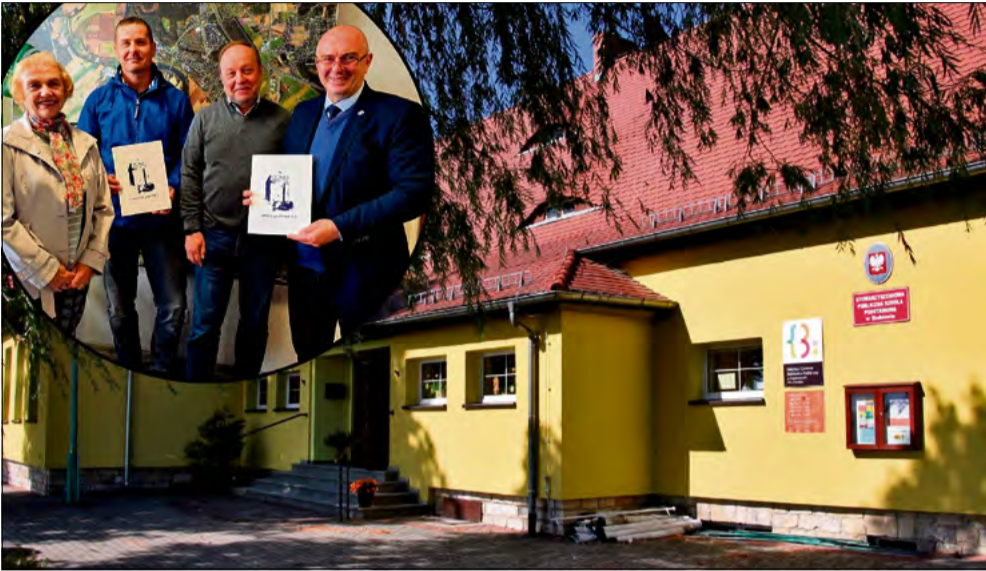
Remont przeprowadzi krapkowska firma BUDOPAP.
