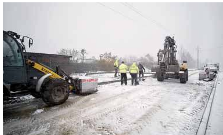
Modernizacja ul. Opinogórskiej w Ciechanowie
