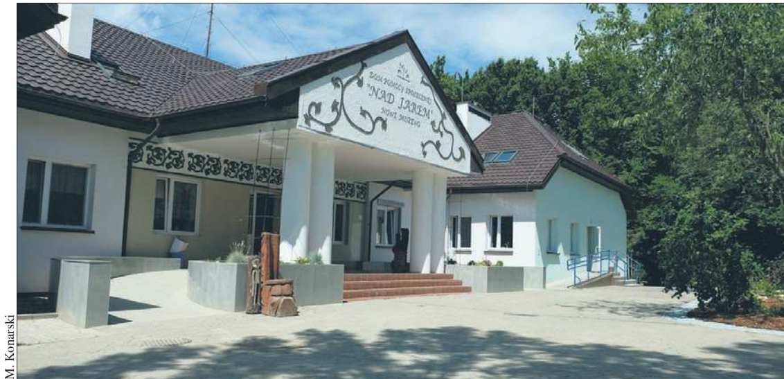
Odnowiony budynek Domu Pomocy Społecznej w Nowym Miszewie
