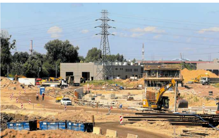
• Budowa II linii metra, baza Karolin FOT. JACEK MARCZEWSKI / AGENCJA WYBORCZA.PL
