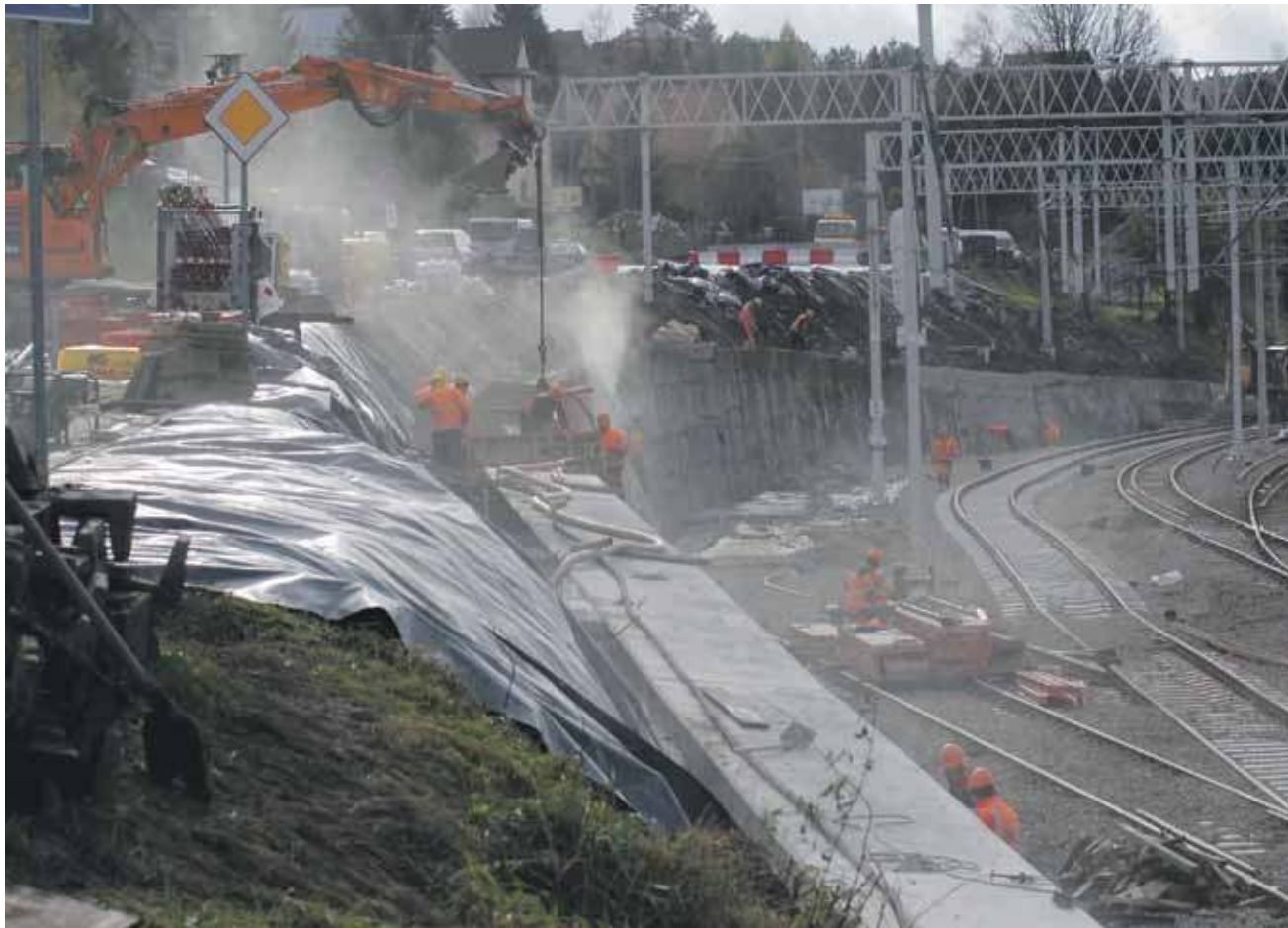
Prace prowadzone przez PKP, przy umocnieniu skarpy rozdzielającej drogę i torowisko - idą pełną parą. Tymczasem rabczański samorząd ma kłopoty z wyłonieniem wykonawcy.
