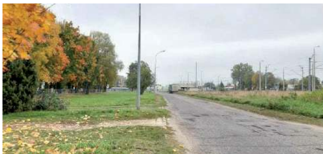
Obecny stan ul. Kusocińskiego nie zapewnia bezpieczeństwa osobom poruszającym się tą drogą. Budowa chodnika za 90 tys. zł ma to bezpieczeństwo poprawić
