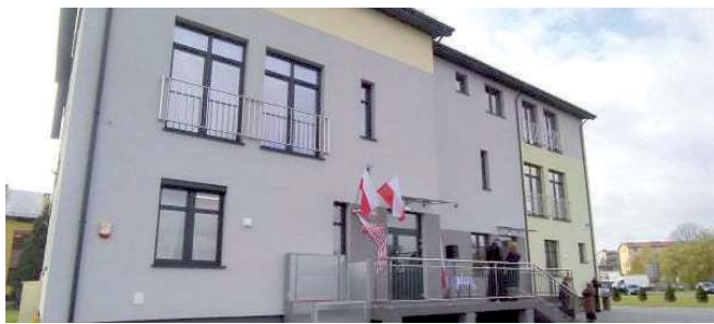
Przedszkole mieści się w budynku przy ul. Janowskiej 55, koło Katolickiego Liceum Ogólnokształcącego
