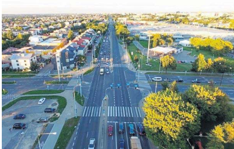
Na skrzyżowaniu zostanie zrobiona korekta sygnalizacji świetlnej oraz zmiana przeznaczenia pasów ruchu
