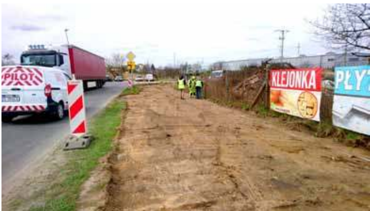
W tym miejscu powstanie wygodna i bezpieczna ścieżka dla pieszych i rowerzystów
