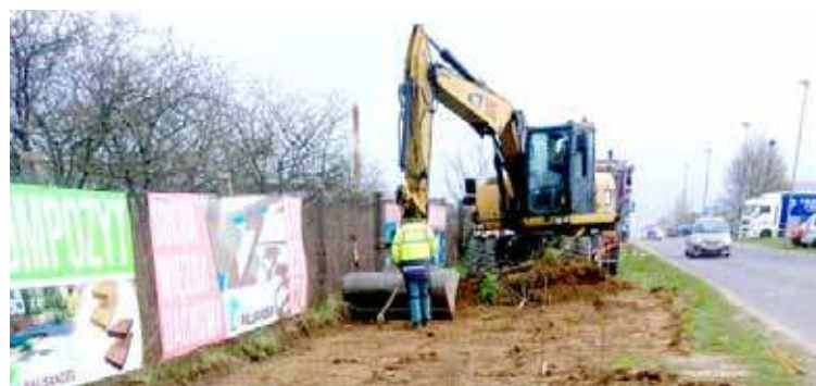
Obecnie przy ulicy Nasiennej trwają prace rozbiórkowe i roboty ziemne
