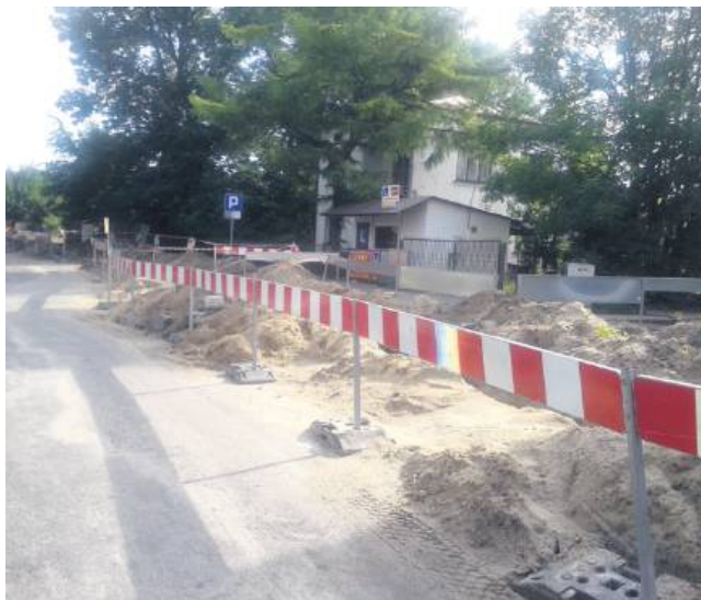
Budowa obwodnicy zachodniej odciążałaby ruch samochodów w mieście.
